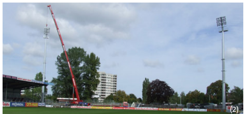
(2) Montage der komplett vormontierten Masten
