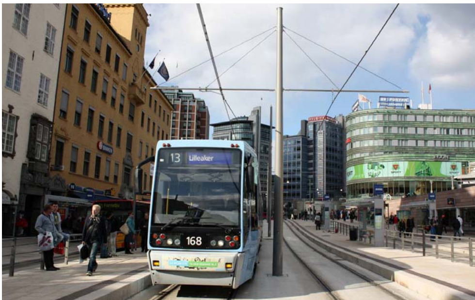
Die Masten wurden als rund-konische Stahlmasten mit Freilängen zwischen acht und 12 Metern sowie in rund-abgesetzter Form ausgeführt.
