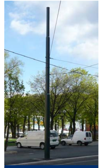
Rund abgesetzter Stahlmast mit Anti-Graffiti-Beschichtung
