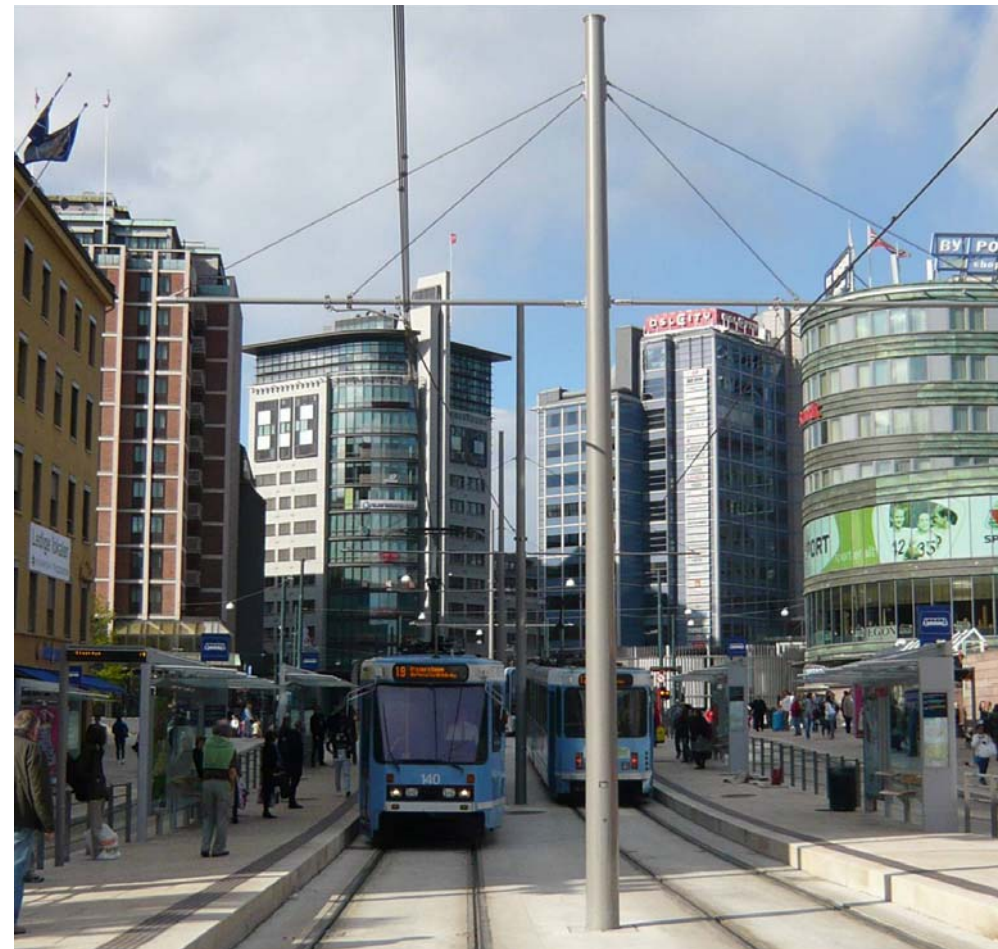
Perfekt in das Osloer Gesamtkonzept integriert: Die neun individuell gefertigten Oberleitungsmasten von Eurocoles.
