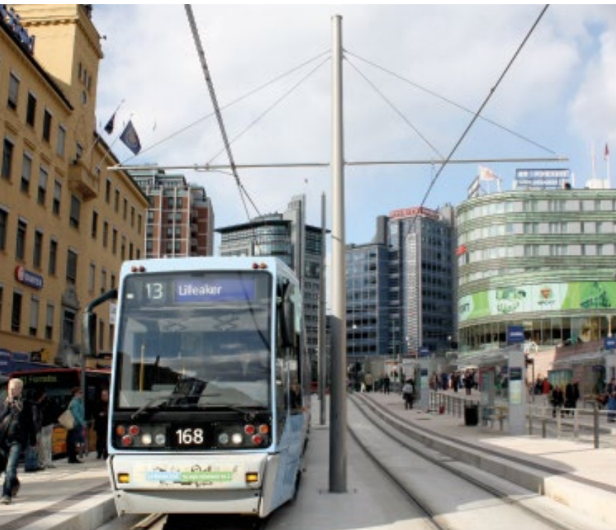
Oberleitungsmast Oslo – schlanke Designlösung
