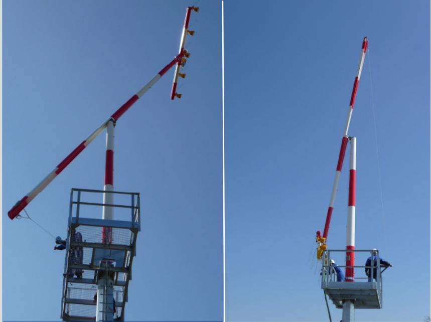
Bild links: Abklappen des Mastes mit Hilfe einer Seilwinde
